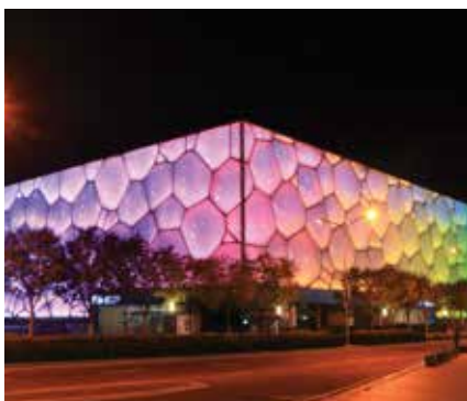
แสงสว่างเปลือกอาคาร
